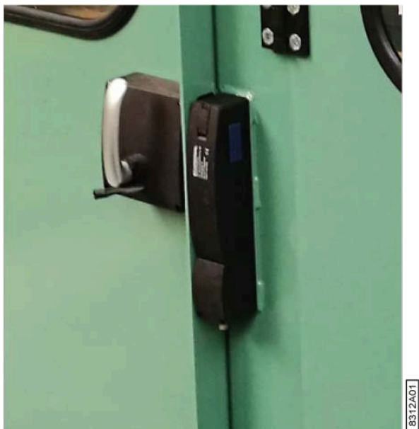
Fig. 16: Détail de capteur (2)
